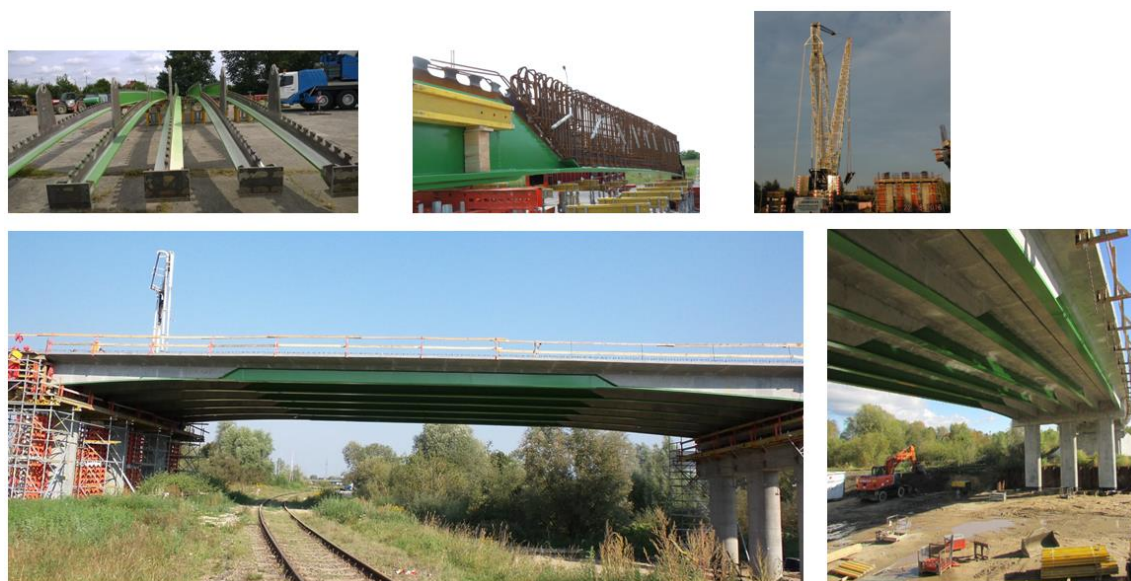
Slika 41: Daljnji razvoj Precobeam tehnologije, čelični hrptovi promjenjive visine
