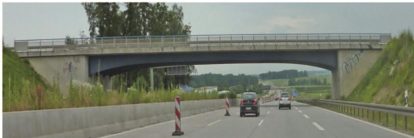
Slika 1: Vruće pocinčani most u Njemačkoj - pogled
