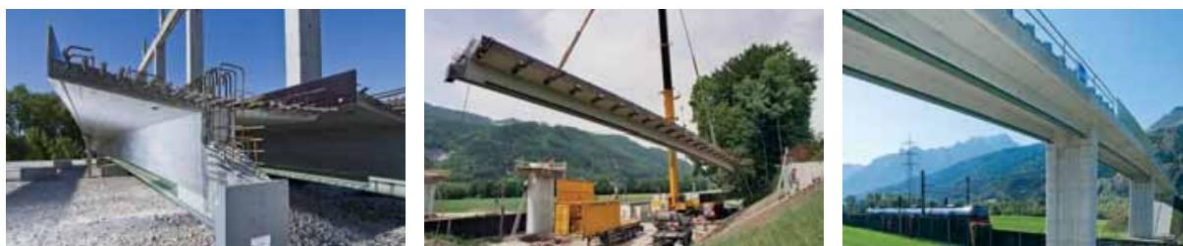
Slika 40: Precobeam korišten na mostu Vigaun, Austria
