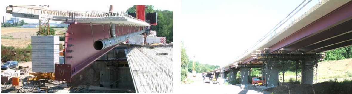
Slika 45: Predgotovljeni spregnuti nosač, slučaj E2
